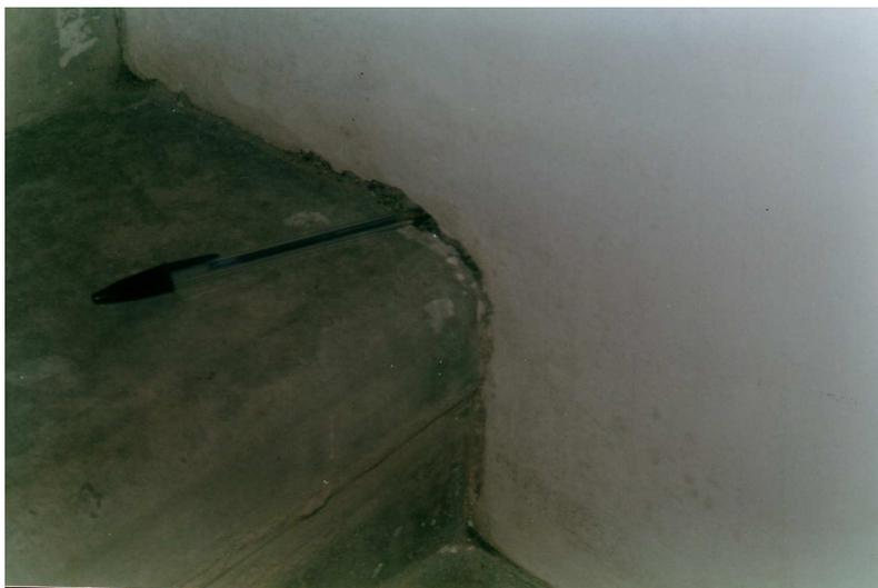
FOTO 2 – Falha estrutural – deslocamento da escada.
