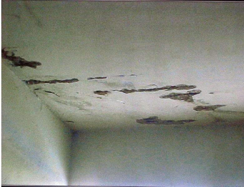
Foto 5 – Infiltração grave no teto da edificação.
