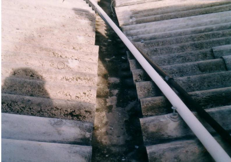
Foto 7 – Defeito no telhado, manta de impermeabilização destacando.
