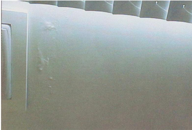
Foto 6 – Infiltração na parede.
