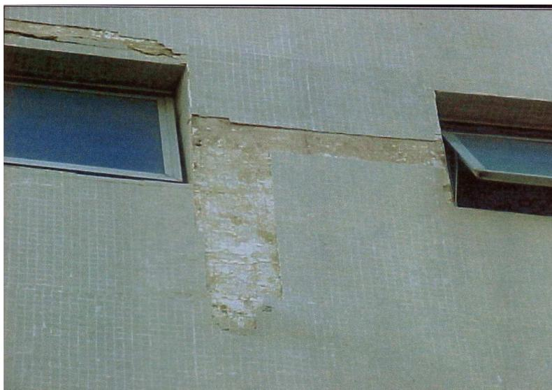
FOTO 3 – Desagregação do revestimento externo.
