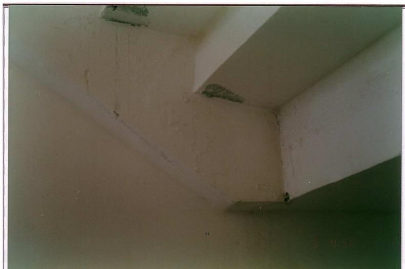
FOTO 4 – Desagregação do revestimento interno
