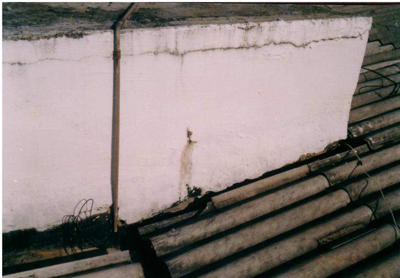
Foto 8 – Quebra do telhado e fissura no reservatório superior.
