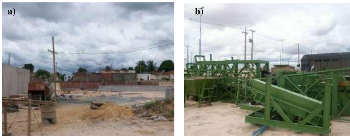
Figura 4.4 – Construção e equipamentos para a instalação da usina de RCD (2007).
