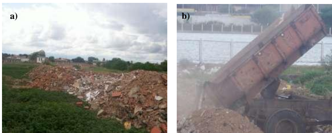
Figura 4.6 – Disposição e descarrego dos Entulhos no Ponto de Deposição
