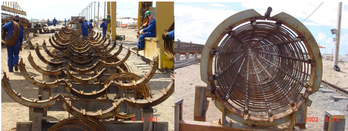
Figura 3.5 - Montagem de armadura: Gabarito de montagem e Armadura montada
