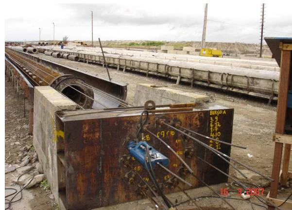
Figura 3.7 – Locação de cordoalhas e aplicação de carga
