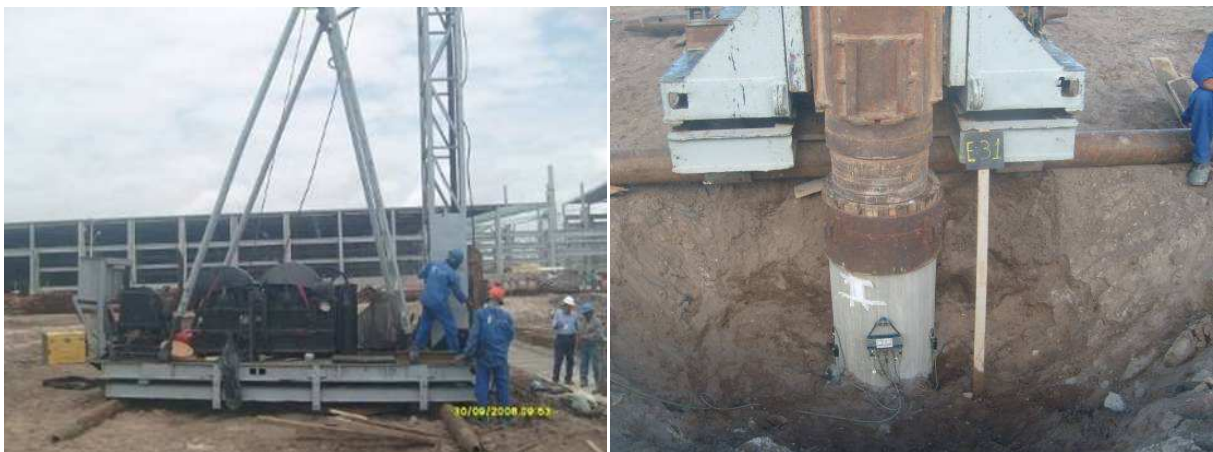
Figura 3.13 – Martelo de queda-livre (Bate-estaca), detalhe coxim e transdutores/acelerômetros
