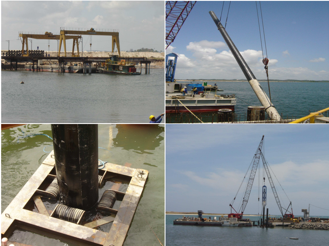
Figura 3.10 – Sequência executiva: Transporte, içamento, gabarito e cravação
