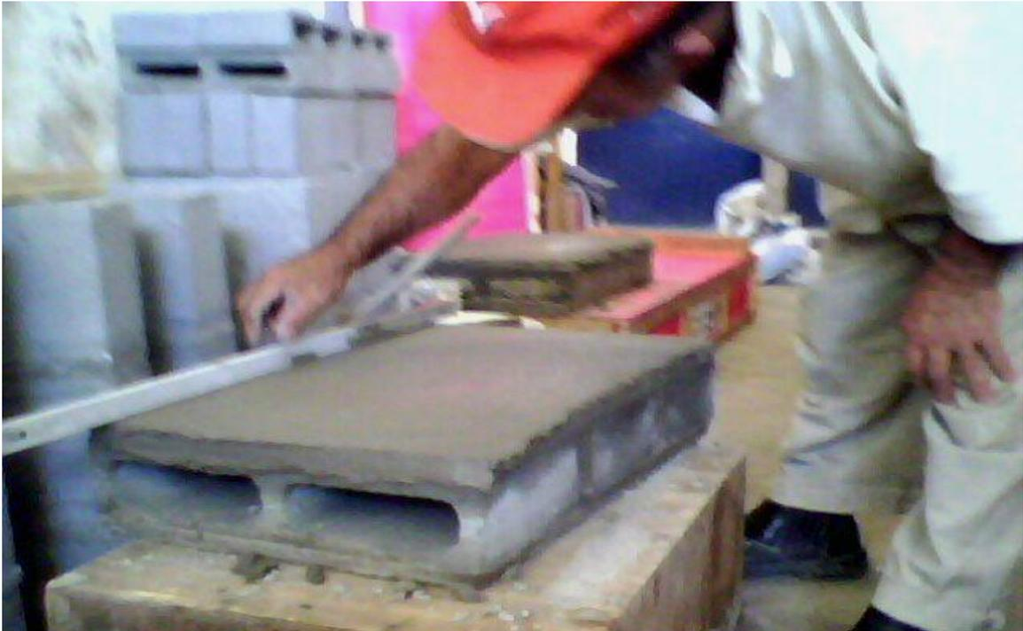
**Figura 4.6.1-4 Revestimento dos painéis – Acabamento superficial**
