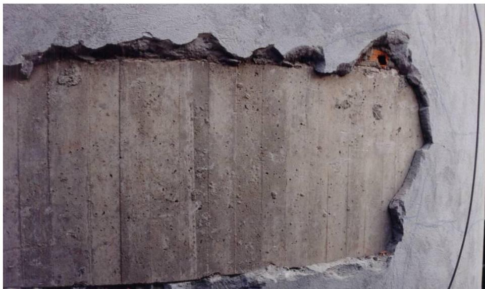
**Figura 1.1-3 Descolamento de revestimentos de argamassa aplicados sobre estruturas de concreto. Fonte: Estudos de casos brasileiros (CARASEK; CASCUDO, JUCÁ, 2005)**
