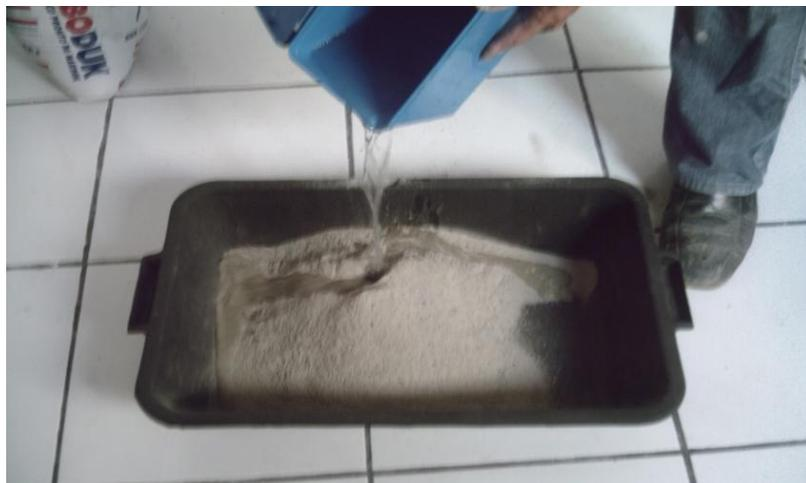
**Figura 4.6.1-2** Adição da água de amassamento
