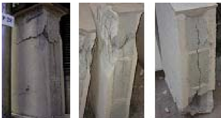
Figura 2.12 - Ruptura dos prismas com revestimento, com tela e conectores
