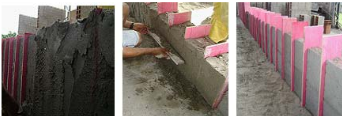
Figura 3.26 -Aplicação da camada de revestimento
