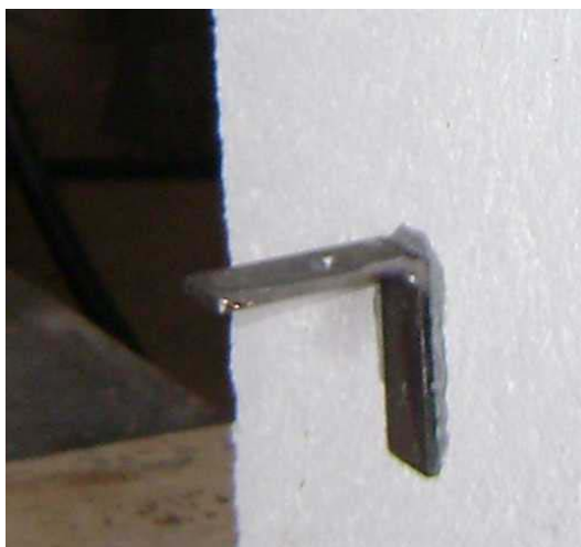
Figura 3.30 - Placa de apoio inferior
