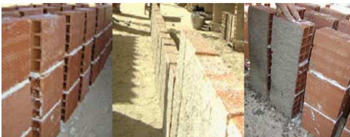
Figura 3.25 - Aplicação do chapisco
