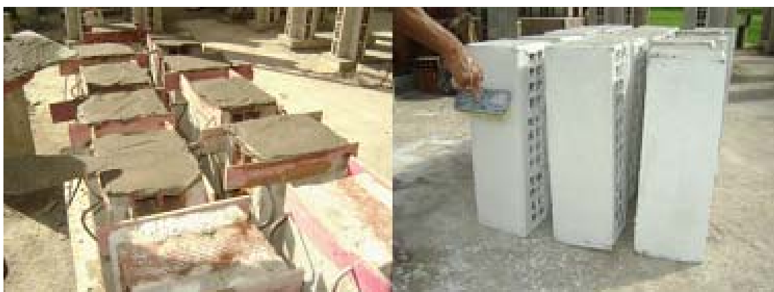
Figura 3.28 - Capeamento e pintura dos prismas
