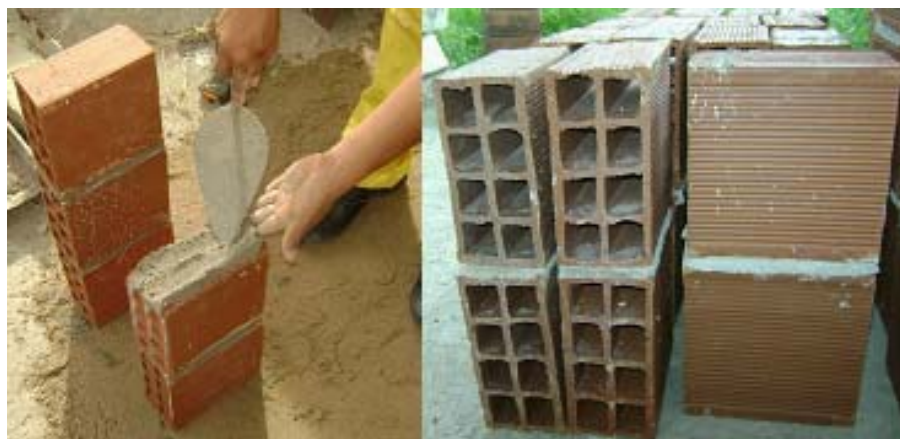
Figura 3.24 - Argamassa de assentamento com 1 cm de espessura
