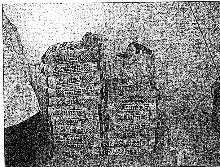
FOTO 16 – Argamassa comprada para o rejunte das cerâmicas
