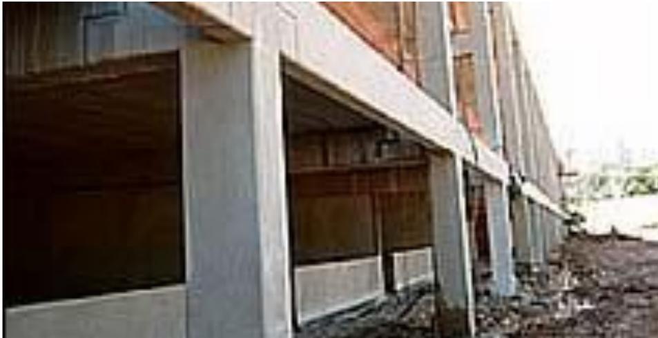
Figura 21: Estrutura Pré-Moldada / Fonte: Sposto; 2008.
