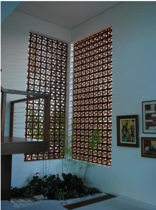
Figura 17: Paredes vazadas por cobogós,
