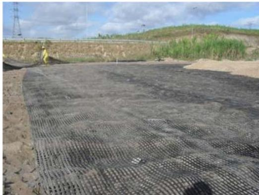
Figura 3.20 - Geogrelha instalada no trecho IV
