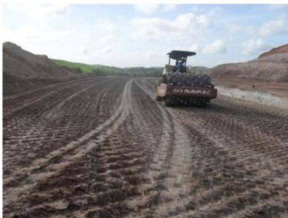
Figura 3.21 - Serviço de compactação executado com rolo vibratório no trecho III
