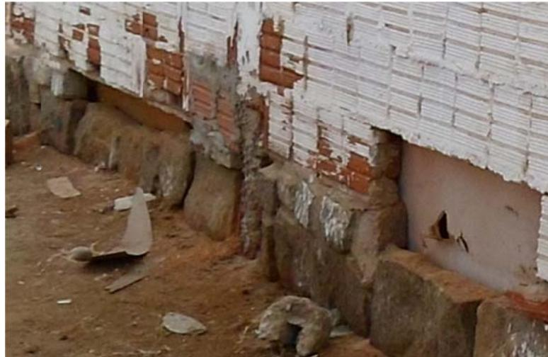
**Figura 3. 10 - Tijolos da alvenaria degradados e transformados em pó - Fonte: O autor**
