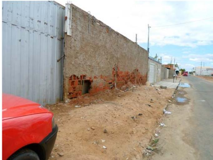
**Figura 3.6 - Edificação apresentando alvenaria em decomposição bairro Dom Malan - Fonte: O autor**
