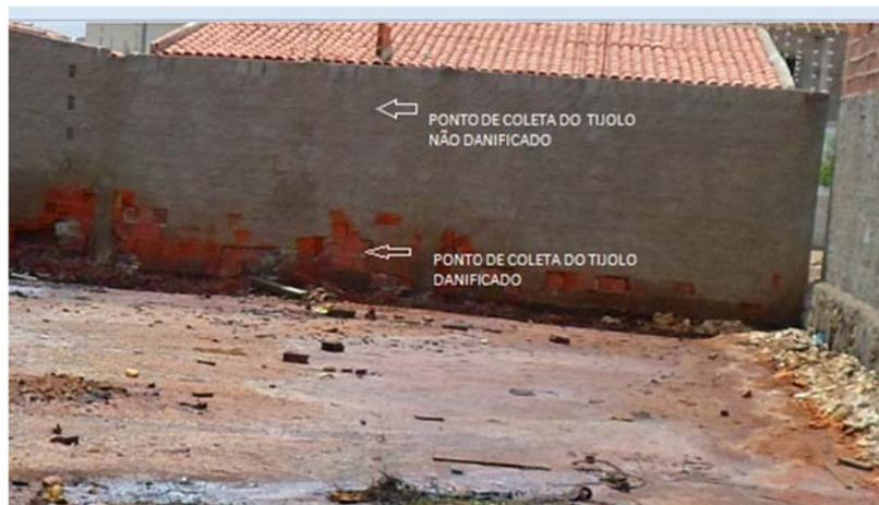
**Figura 3. 25 - Pontos de retiradas das amostras dos tijolos próximo ao Raso da Catarina - Fonte: O autor em 09/10/2012**
