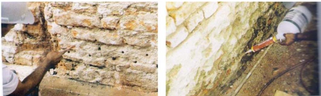
**Figura 2. 7 - Execução de barreiras contra umidade por capilaridade - Fonte: NAPPI e MARQUES, 2010**
