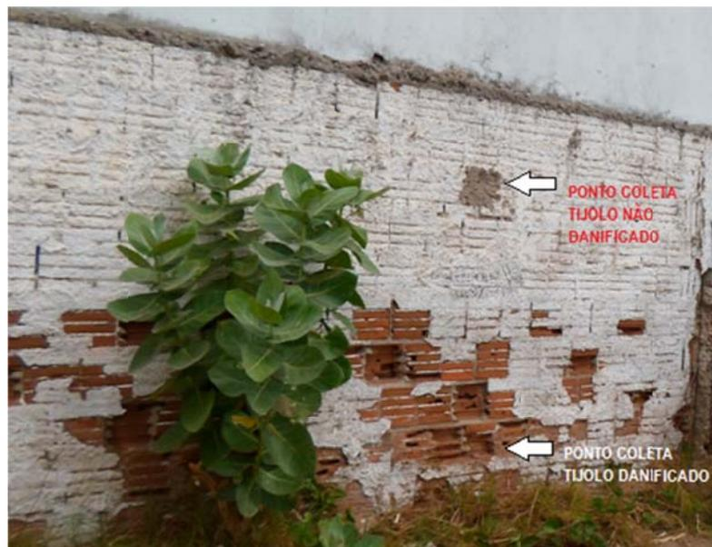
Figura 3. 29 - Pontos de retiradas das amostras dos tijolos - Bairro Vila Eduardo – Fonte: O autor em 09/10/2012
