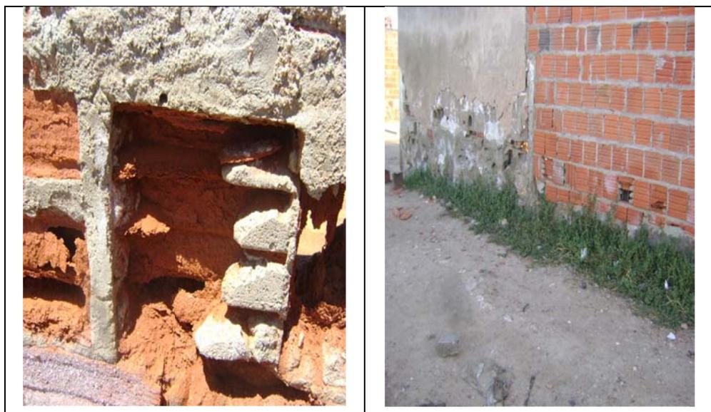
Figura 3. 24 - Detalhe tijolo danificado e não danificado- Fonte: O autor em 29/05/2012
