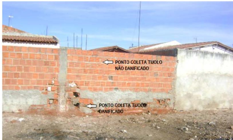
Figura 3. 26 - Pontos de retiradas amostras tijolos - Bairro Antônio Cassimiro- Fonte: O autor em 09/10/2012
