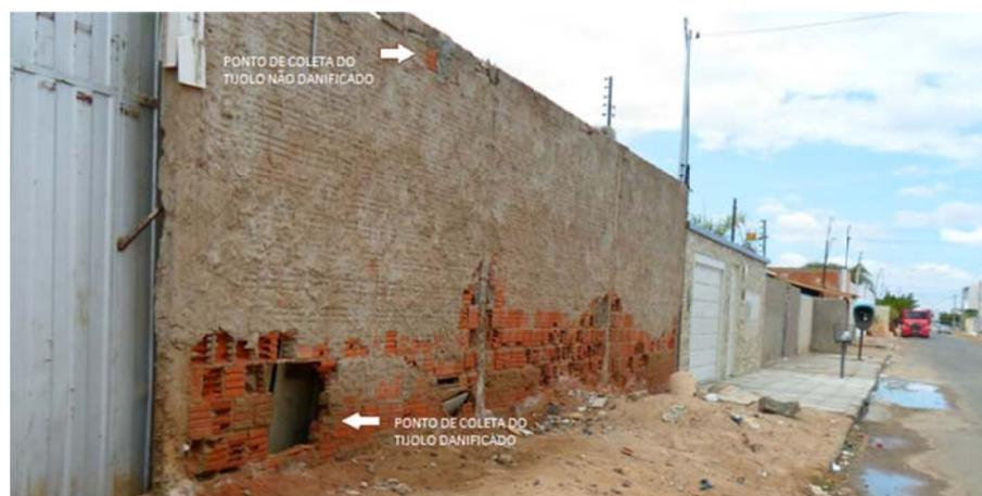
Figura 3. 27 - Pontos retiradas amostras dos tijolos - Jardim Amazonas- Fonte: O autor em 09/10/2012
