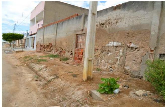
**Figura 3.5 - Edificação com alvenaria em decomposição no Jardim Amazonas - Fonte: O autor**
