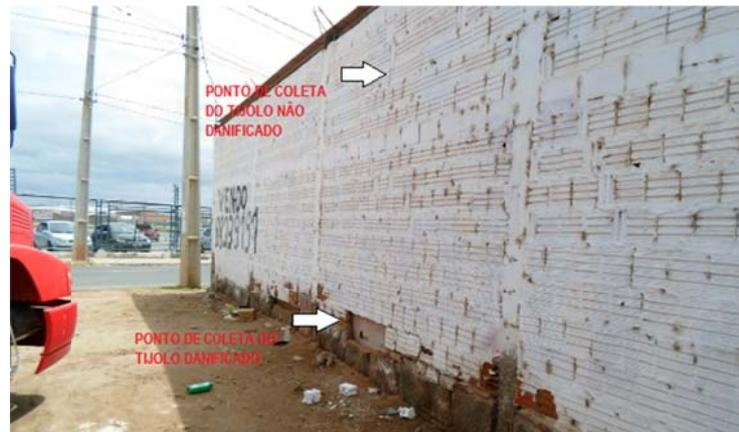
Figura 3. 28 - Pontos retiradas amostras dos tijolos - Bairro Dom Malan - Fonte: O autor em 09/10/2012
