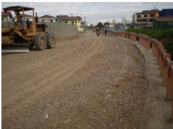
Figura 2.11: Revestimento de via com agregado reciclado
