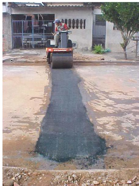
Figura 2.17: Aplicação da camada final com CBUQ
