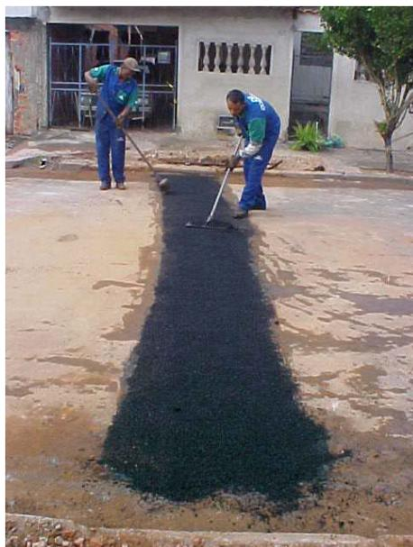
Figura 2.16: Reabilitação de pavimento danificado
