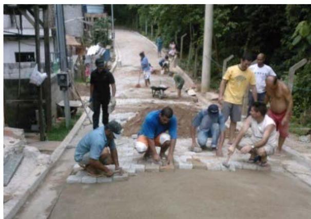
Figura 2.12: Uso de blocos de concreto fabricados com agregado reciclado em pavimentação
