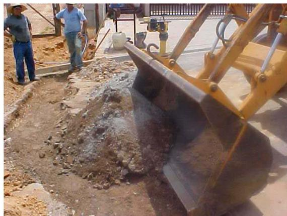
Figura 2.15: Realização da camada de base de bica corrida com RCD
