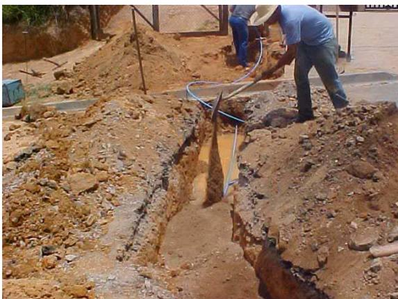
Figura 2.14: Fechamento de vala com RCD após substituição da tubulação de água
