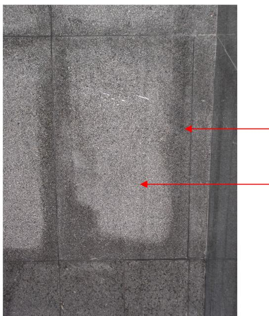
Figura n. 4.17 - Manchas nas placas de rocha do granito escuro (detalhe fachada Sul).
