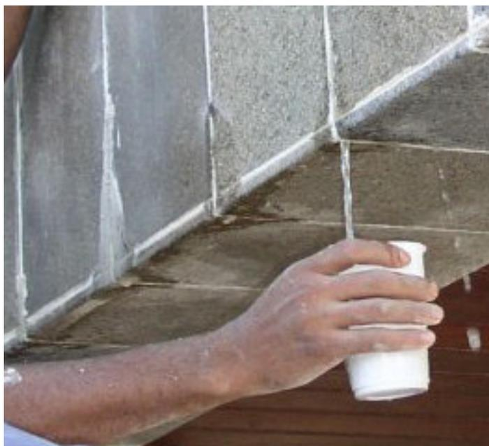
Figura n. 4.32 - Recolhimento da água armazenada sob as placas.
