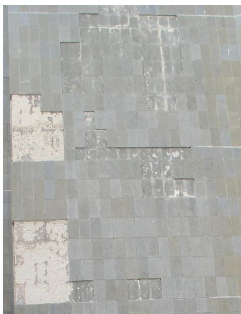
Figura n. 4.34 - Desplacamento na fachada Oeste.
