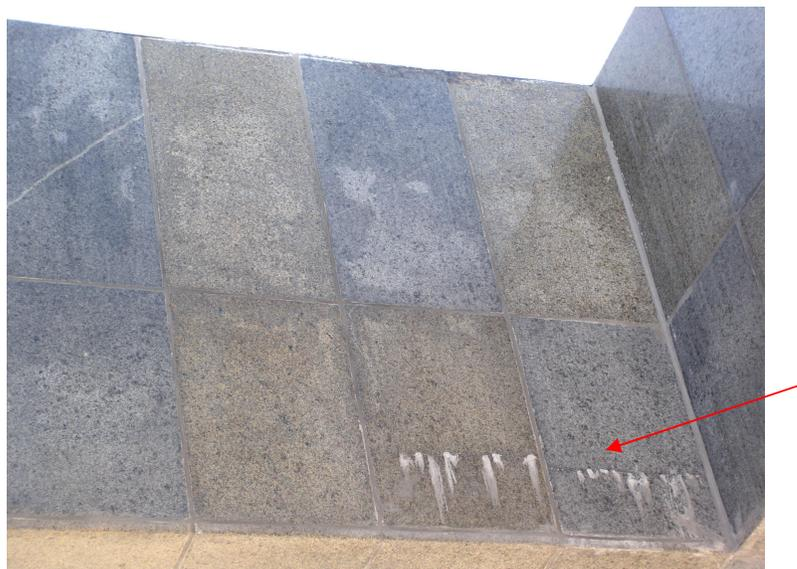
Figura n. 4.22 - Fissuração das placas de rocha.
