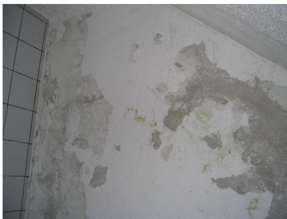
Figura n. 4.26 - Infiltração na parede interna da escada.
