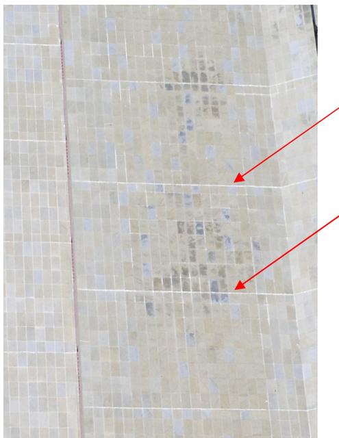
Figura n. 4.27 - Aplicação de juntas de dilatação horizontais na fachada.
