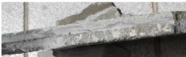
Figura n. 4.37 - Espessura da argamassa de assentamento.
