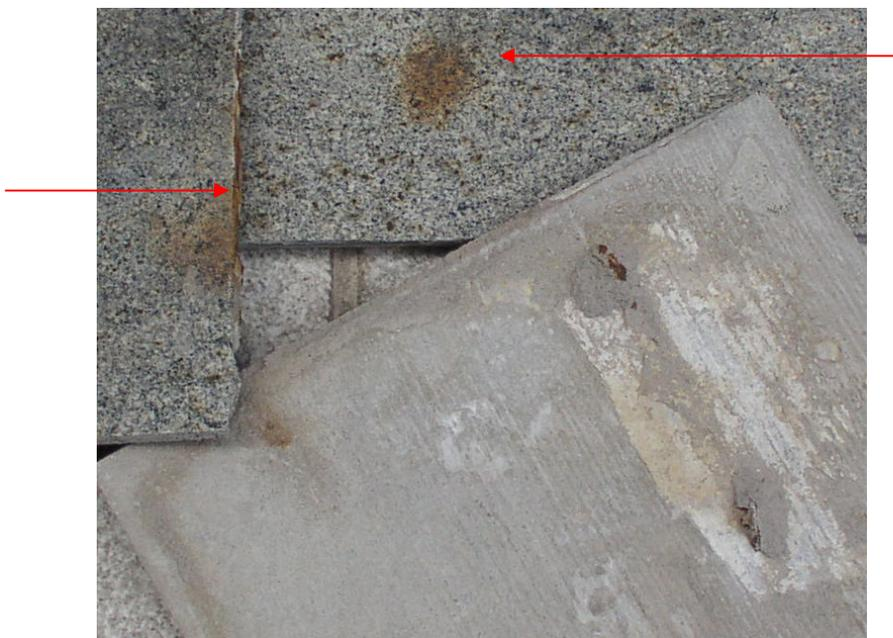
Figura n. 4.42 - Alterações provocadas pela oxidação dos grampos.
