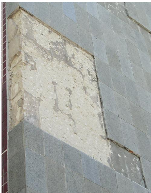
Figura n. 4.35 - Área com deslocamento – substrato, argamassa e placa.
