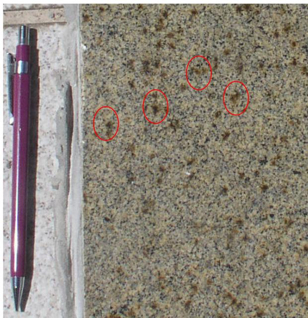
Figura n. 5.03 - Minerais alterados por oxidação.
