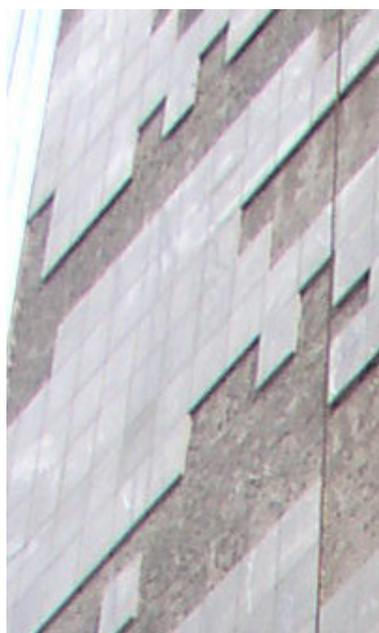
Figura n. 4.33 - Desplacamento na fachada Sul.
