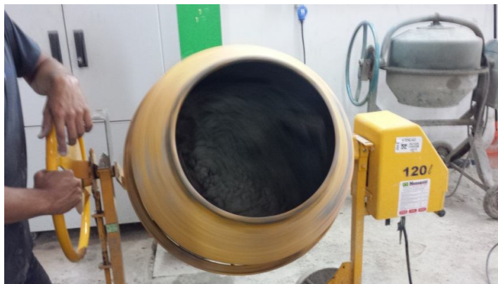
Foto 1 – Mistura do concreto em betoneira de 120 litros
