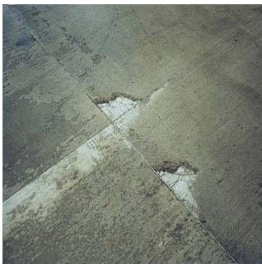
Fig. 3.17 - Desgaste superficial por abrasão
