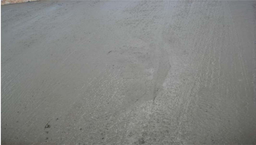
Fig. I.3 – Piso executado sem ocorrência de afloramento excessivo de fibras
