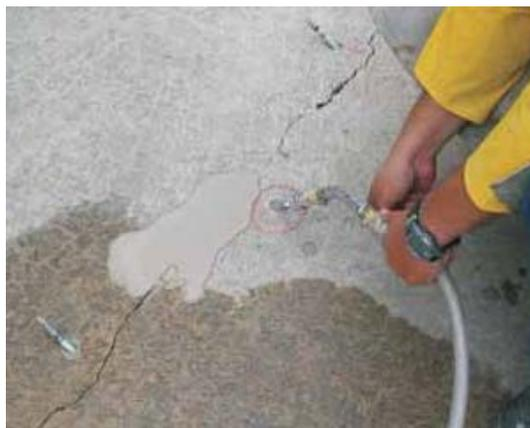
Fig. 3.12 - Tratamento com epóxi semi-rígido
