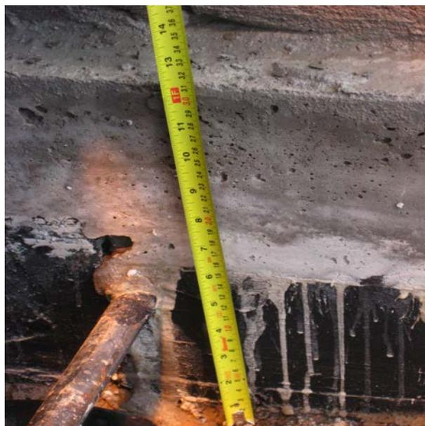
Fig. I.2 – Piso de concreto de 10 cm sobre um piso de 18 cm
