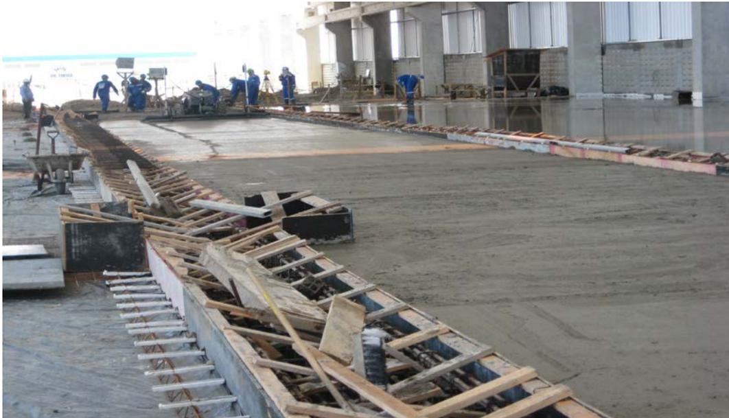
Fig. 1.1 – Piso industrial reforçado com fibras de aço em fase de execução
