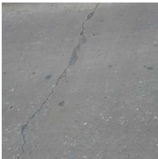
Fig. 3.10 - Fissuras de Retração hidráulica
