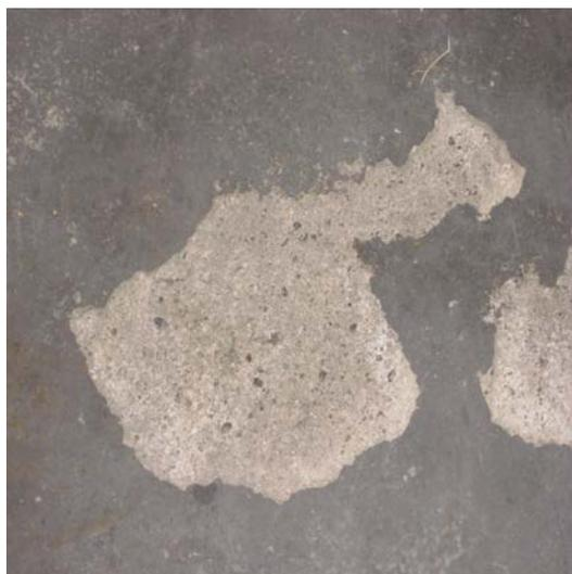
Fig. 3.15 - Delaminação
