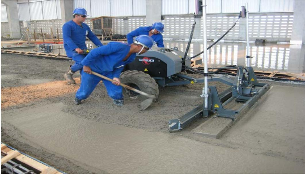
Fig. I.4 – Nivelamento do concreto com equipamento de última geração
