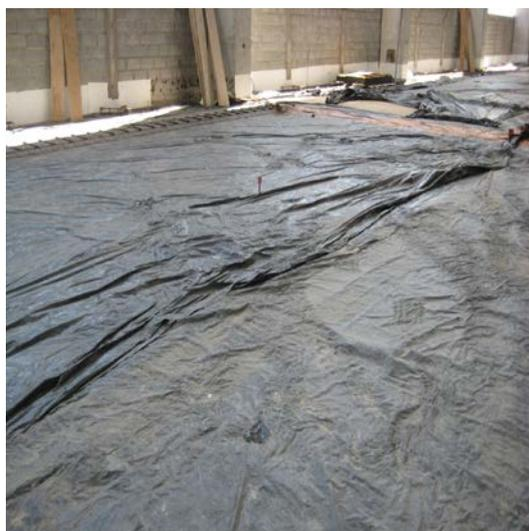
Fig. 3.8 - Lona de polietileno – Piso industrial no Estaleiro de Suape/PE
