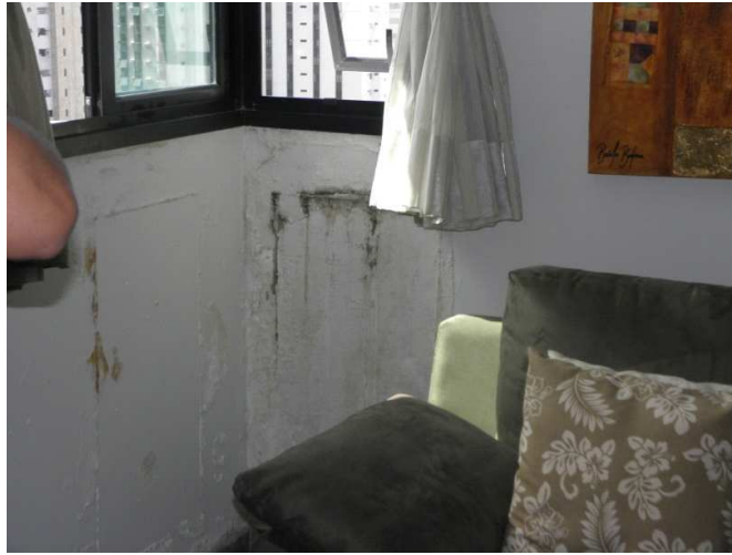
Figura 11-Bolhas e desagregação do revestimento de pintura interna na unidade residencial.
