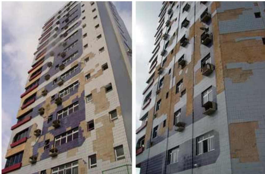
Figura 1 - Destacamentos de revestimento cerâmico em fachada Fonte:( http://www.aecweb.com.br )
