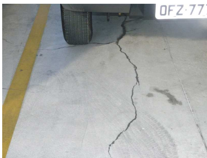
Figura 12 - Fissuras no piso do pavimento semi-enterrado.
