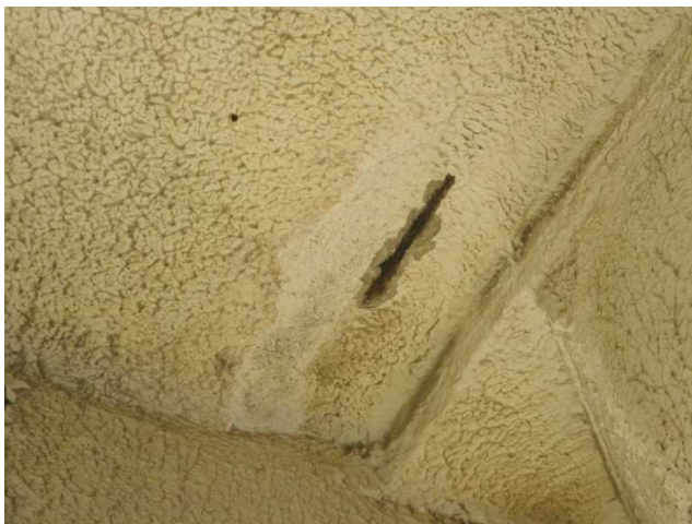
Figura 24 – Corrosão da ferragem da estrutura da laje do 1º piso garagem
