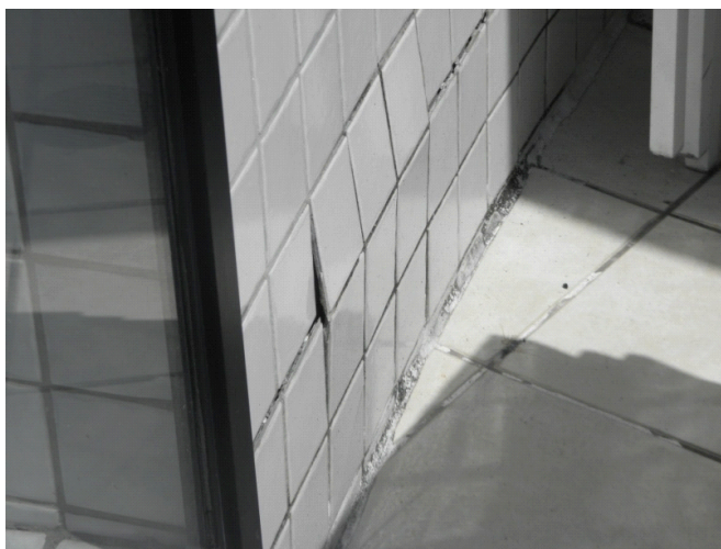
Figura 9 – Descolamento do revestimento cerâmico da parede do pavimento vazado;
