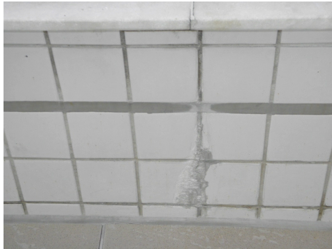
Figura 13– Eflorescência no revestimento cerâmico da mureta da piscina
