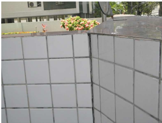
Figura 22 – Fissura na parede do pavimento garagem
