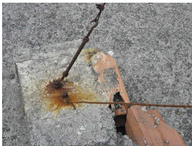
Figura 27 – Corrosão precoce dos cabos e parafusos do estaiamento do mastro do pára-raios.
