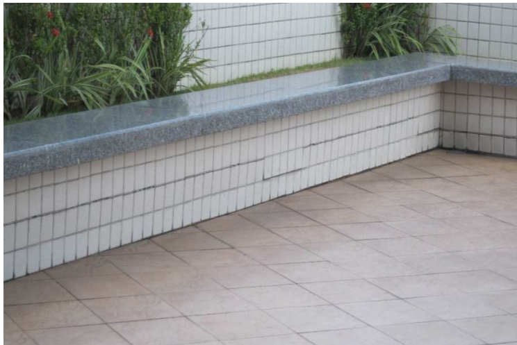
Figura 29 – Fissuras no revestimento em placas cerâmicas das paredes da jardineira do pavimento térreo.
