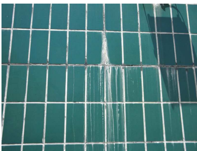
Figura 19 – Eflorescências nos revestimentos cerâmicos de fachada no reservatório d'água superior.
