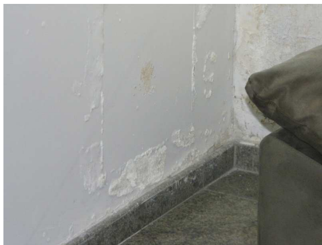
Figura 10 - Bolhas e desagregação do revestimento de pintura interna na unidade residencial.
