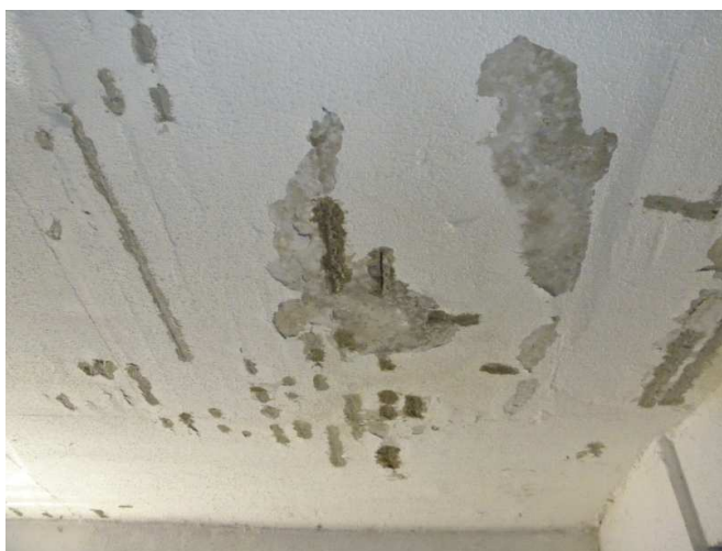
Figura 17- Deterioração de estruturas de concreto armado da laje do primeiro pavimento garagem.
