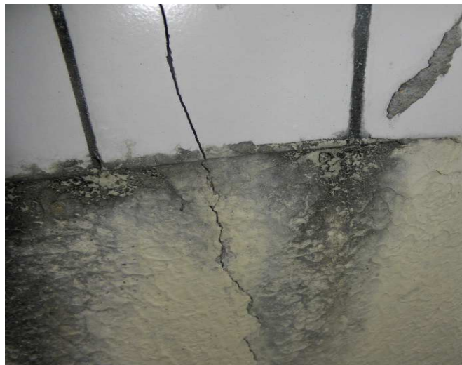
Figura 15 – Fissura na alvenaria e infiltrações no pavimento térreo. Fonte: Autor
