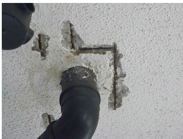
Figura 25 – Corrosão da ferragem da estrutura da laje do 1º piso garagem
