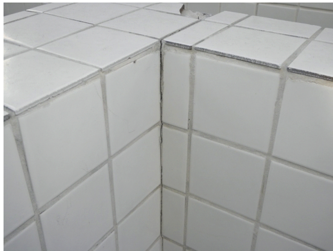
Figura 14 – Fissura na parede do pavimento térreo
