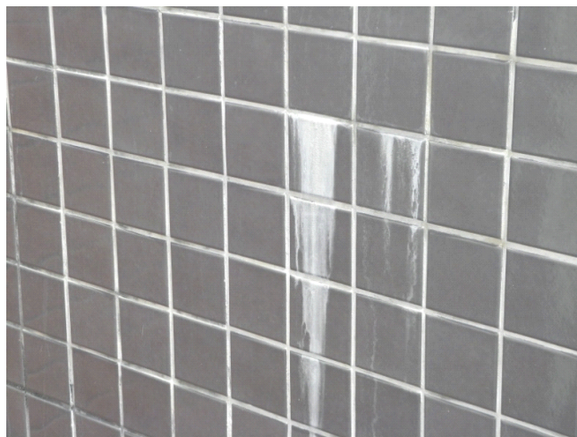
Figura 26 – Eflorescências nos revestimentos cerâmicos de fachada
