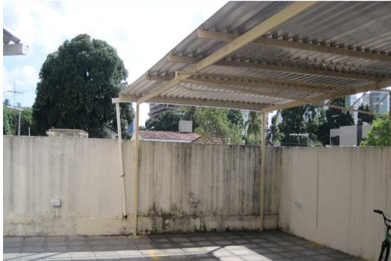
Figura 32 – Instalação de cobertura de veículos com fixação dos pilaretes sobre o piso do estacionamento.
