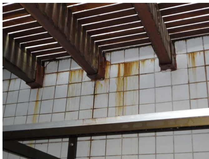
Figura 33 – Infiltrações e eflorescências nas paredes do semi-enterrado
