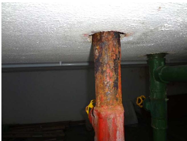
Figura 35 – Oxidação do barrilete do reservatório d'água superior
