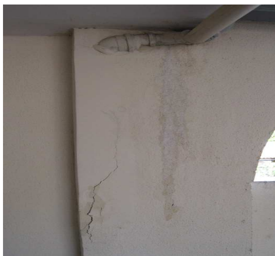
Figura 31 – Vazamentos nas instalações hidrossanitárias.
