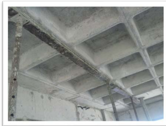
Figura 2 - Faixa de reescoramento
