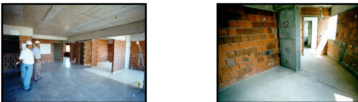
Figura 4.16 – Aspecto geral das obras quanto à limpeza. Fonte: arquivos do autor.
