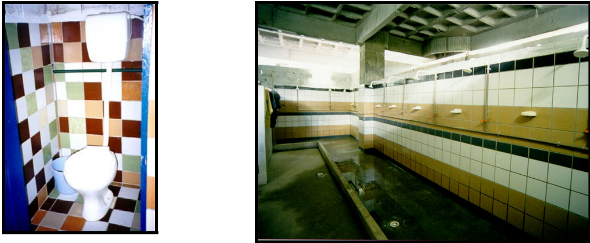
Figura 4.13 – Áreas de vivência – banheiros com revestimento de cerâmica – melhora na higienização e no aspecto geral dos banheiros.
