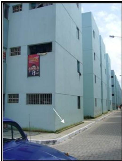
**Figura 64 - fungo na base das paredes**
