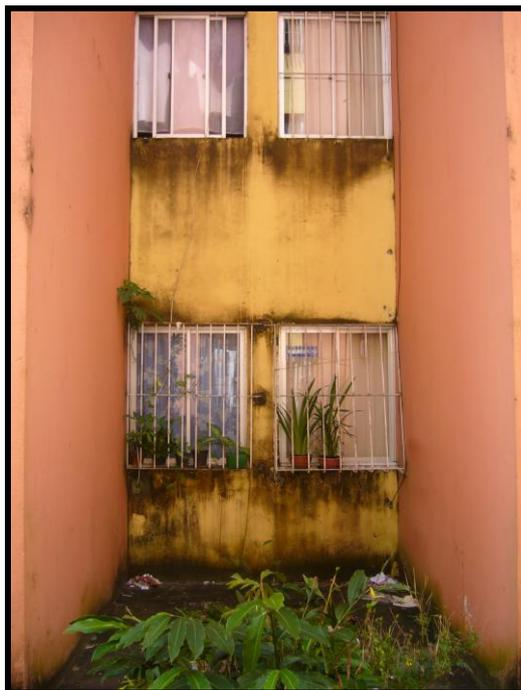
**Figura 47 – presença de fungo nas superfícies recuadas da fachada**
