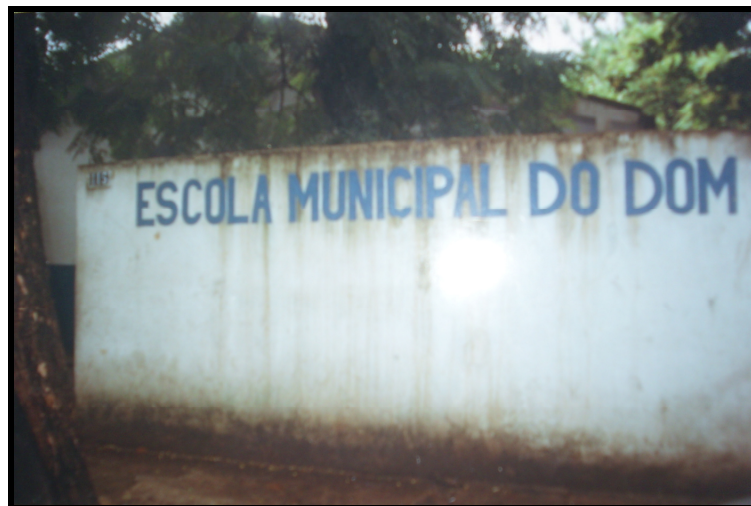
Foto 4 – Muro de entrada da Escola Municipal Escolinha do Dom
