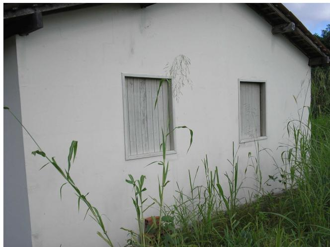
**Figura 5-29 - Vista lateral direita do protótipo apresentando patologia na pintura, devido falha na cobertura**
