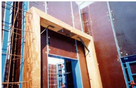
**Figura 2-9 - Sistema Construtivo com Concreto Celular – Instalação de caixilharia**
