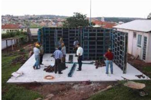
**Figura 2-8 - Sistema Construtivo com Concreto Celular – Montagem das formas**
