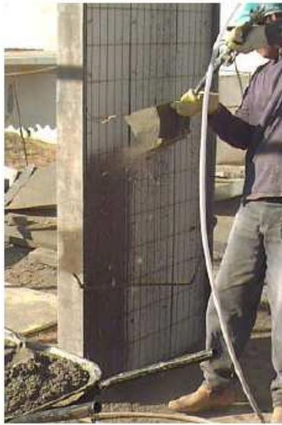
**Figura 3-34 - Projeção de argamassa em painel (BERTINI, 2002)**
