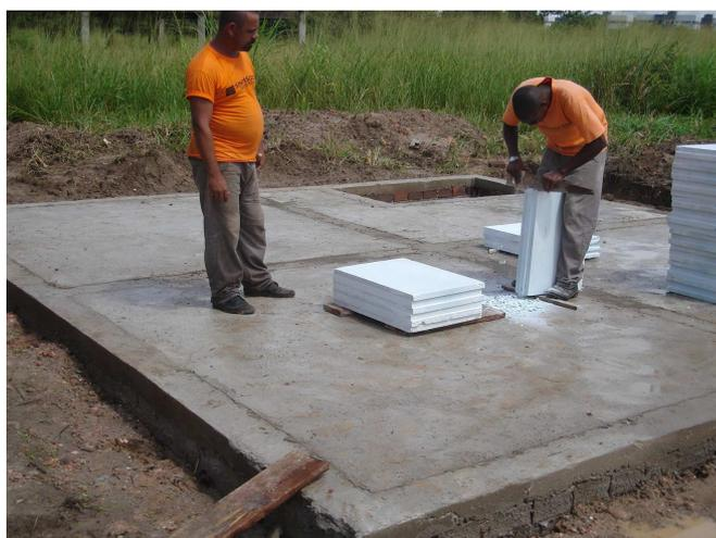
**Figura 5-19 - Piso cimentado sobre aterro apiloado e preparação dos blocos da 1ª fiada (ITEP, 2007-a)**
