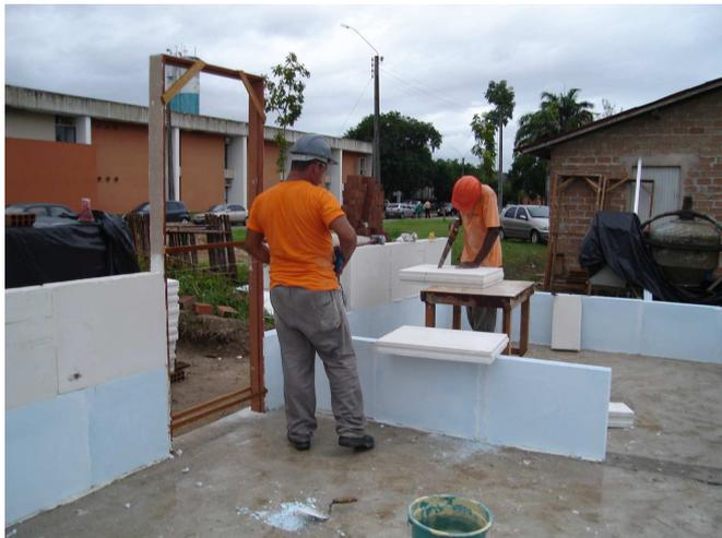
**Figura 5-21 - Fixação da grade de porta e execução da 2ª fiada (ITEP, 2007-a)**
