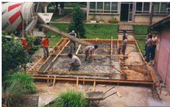
**Figura 3-27 - Preparação da fundação -** (<http://www.tecnocell.com.br/produtos>)
