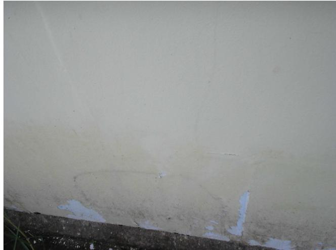
**Figura 5-28 - Vista lateral esquerda do protótipo apresentando patologia da pintura na base**
