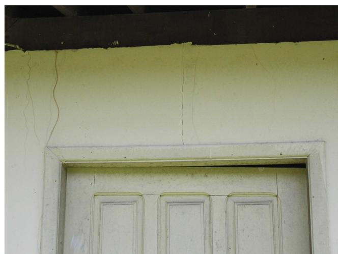
**Figura 5-30 - Vista posterior do protótipo apresentando falha na união de dois blocos acima da porta**
