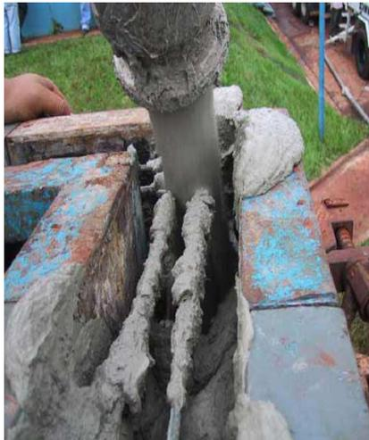
**Figura 2-11 - Sistema Construtivo com Concreto Celular – Lançamento do concreto** (SILVA, 2004)
