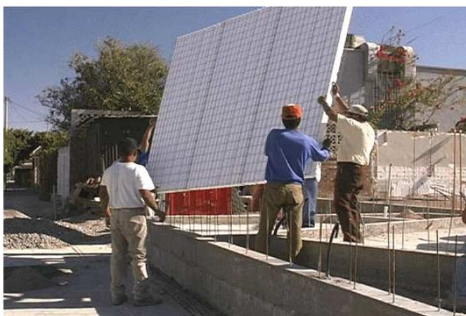
**Figura 3-29 - Montagem dos painéis - (<http://www.tecnocell.com.br/produtos>)**
