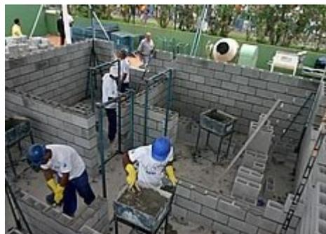
**Figura 2-1 - Alvenaria estrutural com blocos de concreto vazado (ABCP, 2009)**
