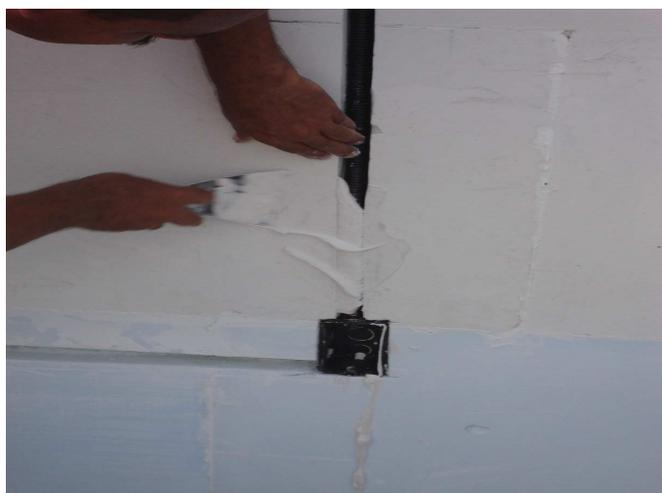
**Figura 5-24 - Fixação dos eletrodutos da instalação elétrica e acabamento (ITEP, 2007-a)**
