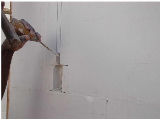
**Figura 5-23 - Execução das instalações- corte prévio com maquina e cabamento (ITEP, 2007-a)**
