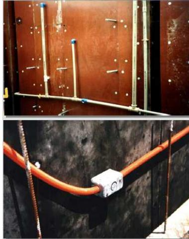
**Figura 2-10 - Sistema Construtivo com Concreto Celular – Instalação elétrica e hidráulica**
