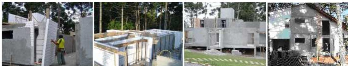
Figura 2-17 - Painel Monolítico simples em montagem - <http://www.tecnocell.com.br/produtos> (acessado em 26/08/08)
