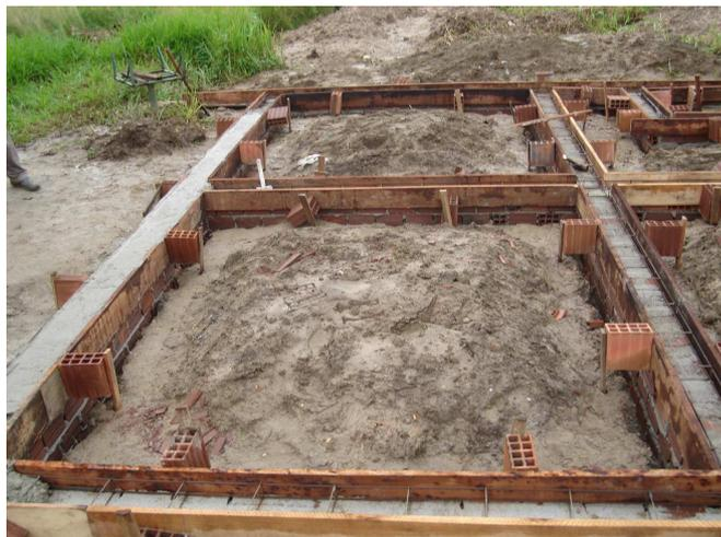
**Figura 5-18 - Execução do embasamento e cinta de concreto armado (radier) sobre o embasamento (ITEP, 2007-a)**
