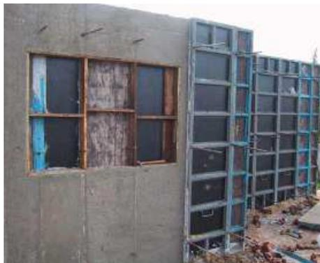
**Figura 2-12 - Sistema Construtivo com Concreto Celular –** (SILVA, 2004)
