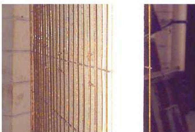
**Figura 3-16 - Detalhe do Painel: EPS + Tela Soldada (BERTINI, 2002)**
