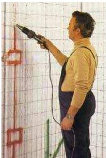
**Figura 3-33 - Abertura de canaletas com um soprador de ar quente**
