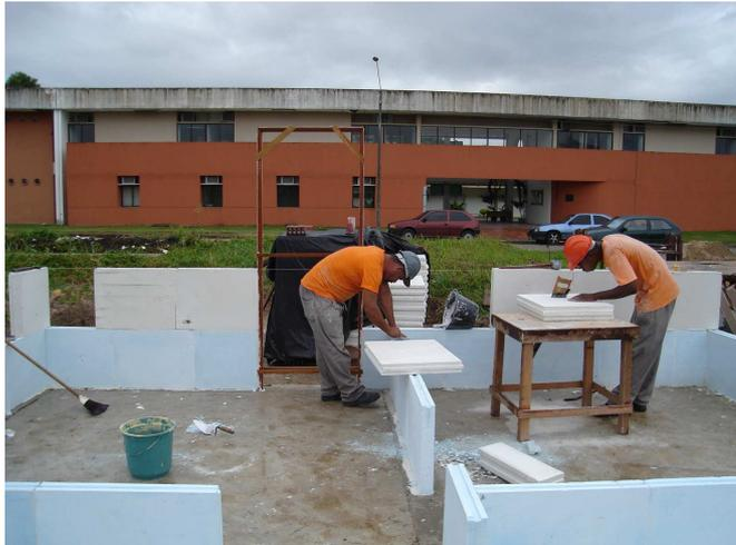
**Figura 5-20 - Execução da 1ª fiada com bloco HIDRO (ITEP, 2007-a)**
