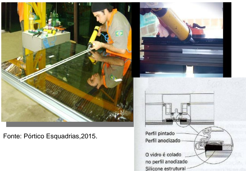
Figura 13 – Sistema de Colagem de vidro.
