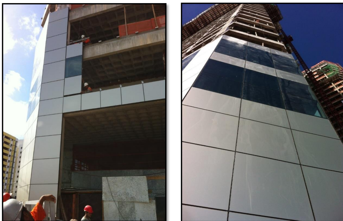
Figura 51 – Montagem dos painéis -Torre C
