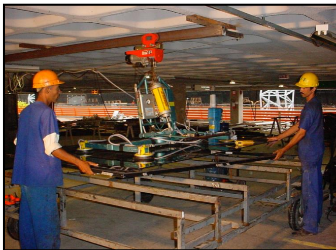
Figuras 52 – Área de colagem na Obra
