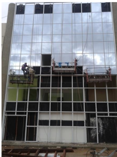
Figura 6 – Esquema de montagem do sistema Stick
