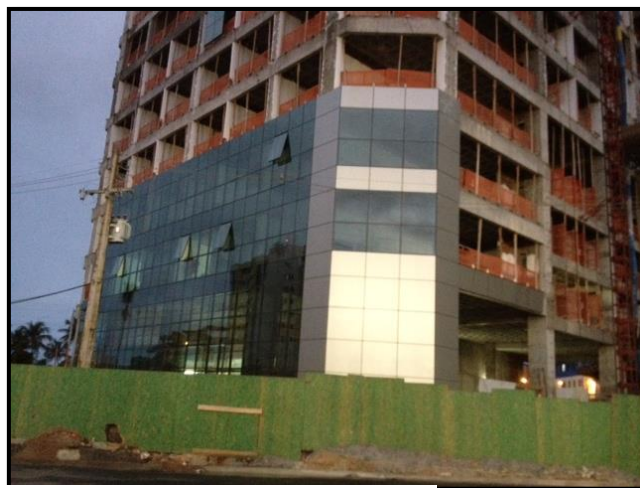
Figura 43 – Início da instalação e montagem – Torre C
