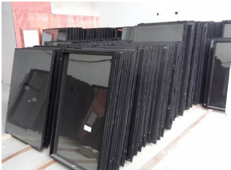
Figura 53 – Área de armazenamento na Obra
