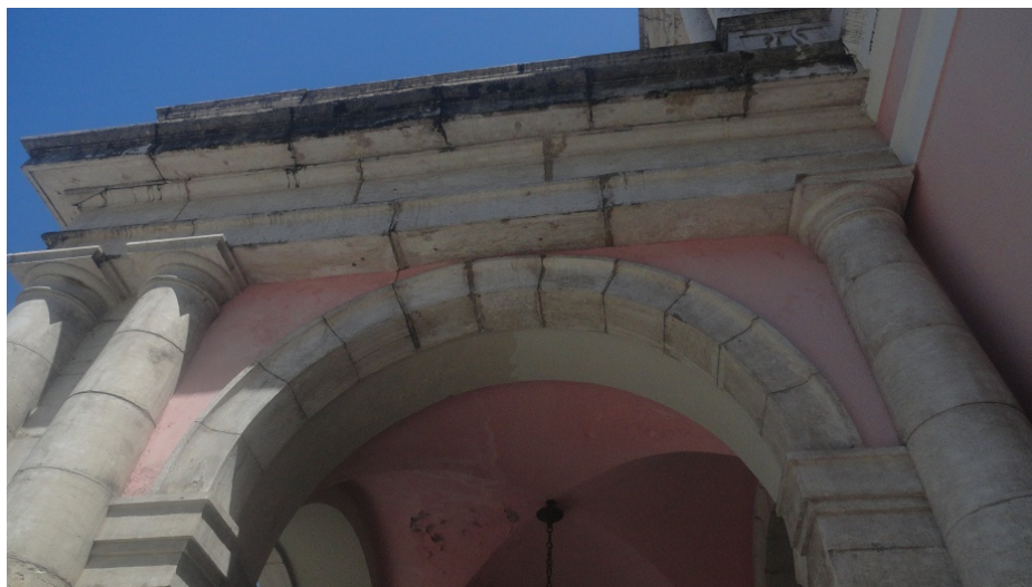
Figura 19 – Manchas negras de diversos particulados
