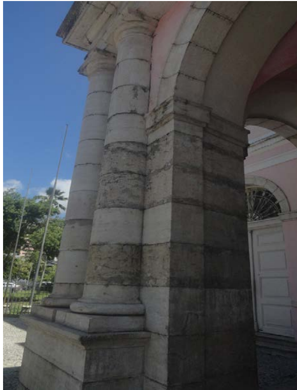
Figura 12 – Pórtico construído em pedra lioz
