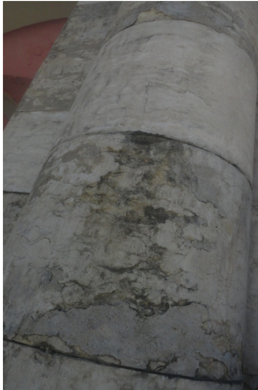
Figura 17 – Desagregação granulométrica do Lioz
