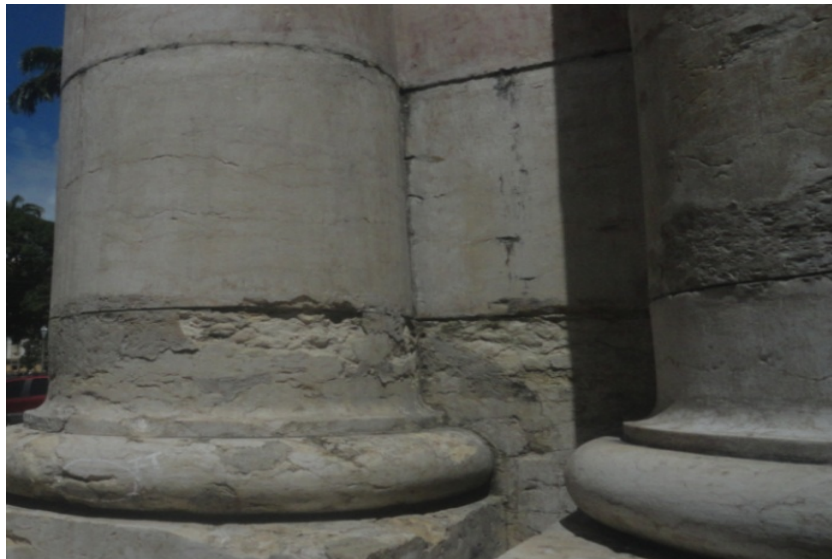
Figura 15 – Degradação mecânica
