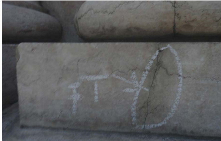
Figura 13 – Fissuras provocadas pela trepidação do trânsito
