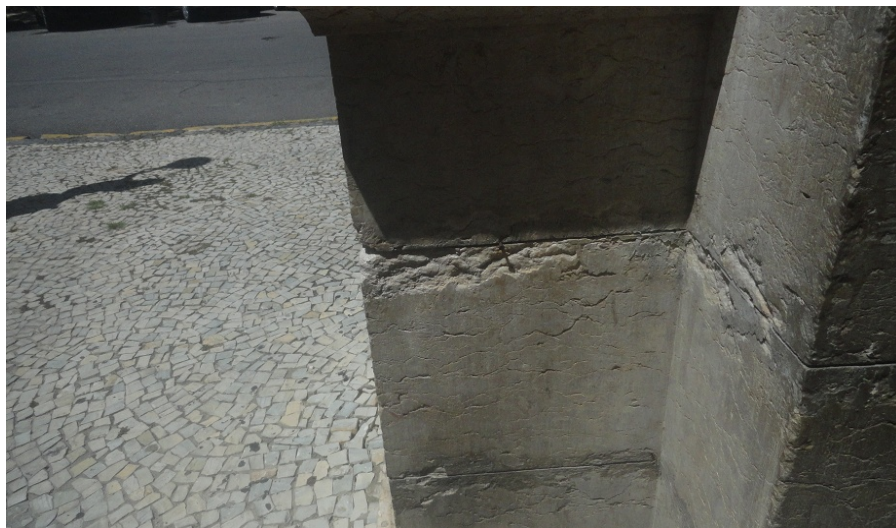
Figura 21 – Dilatação Térmica
