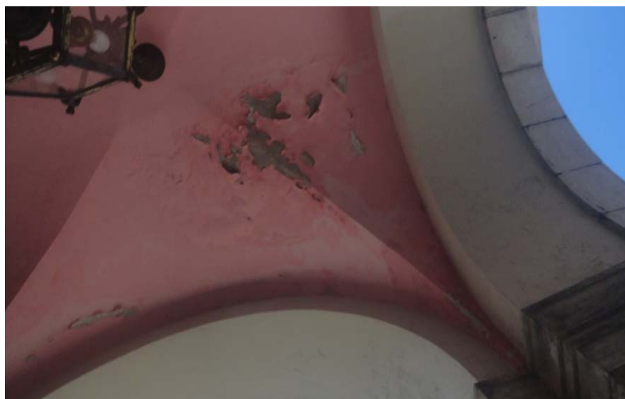
Figura 14– Descamação da pintura
