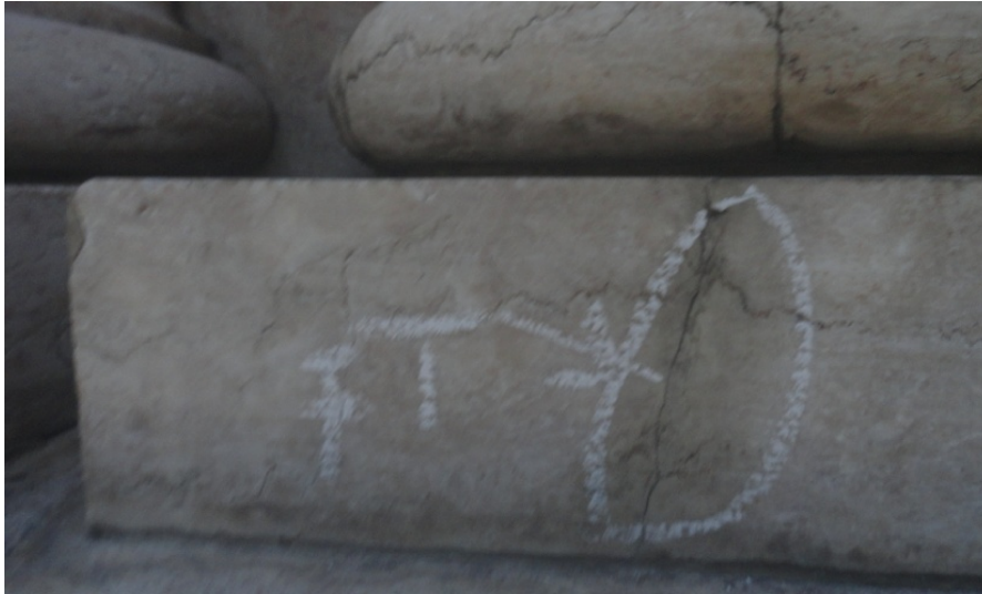
Figura 18 – Fissuras por tensões mecânicas
