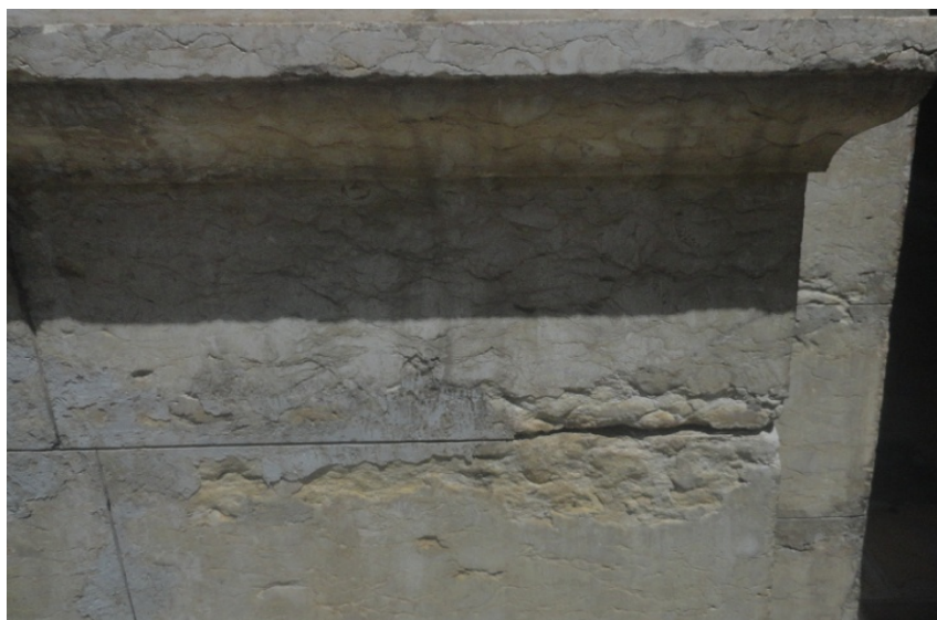
Figura 16 – Dilatação térmica ou esforço de carga
