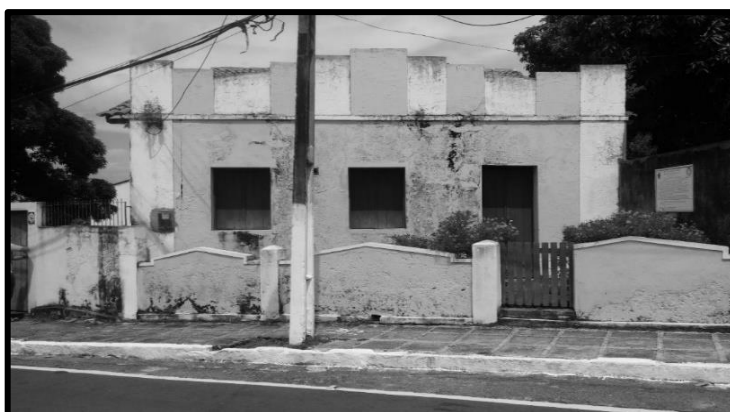
Figura 49: Atual fachada da casa das Missionárias em Nísia Floresta.
