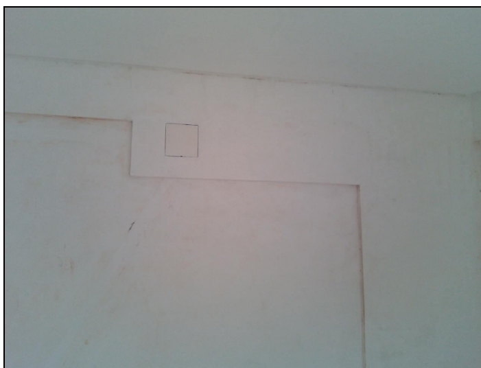
Figura 3.3.16 - Saliência das vigas em relação às paredes
