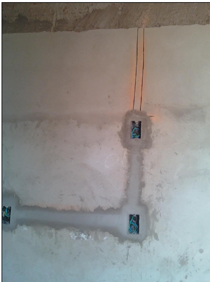
Figura 3.3.20 - Mudança nas instalações elétricas
