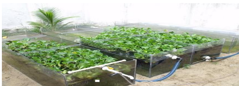
Fig. 2. Wetlands construídos em policarbonato transparente com macrófitas flutuantes
