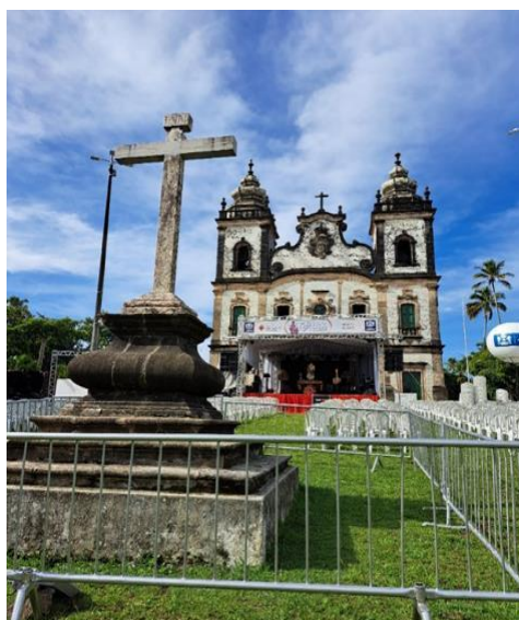
Figura 2- Igreja Nossa Senhora dos Prazeres
