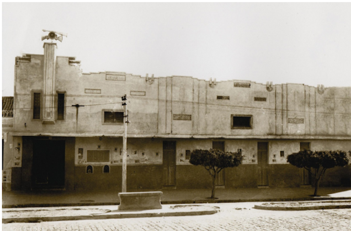
Imagem 5-Grupo - Fachada original do Cinema Rio Branco, (Luiz Wilson, 1993).
