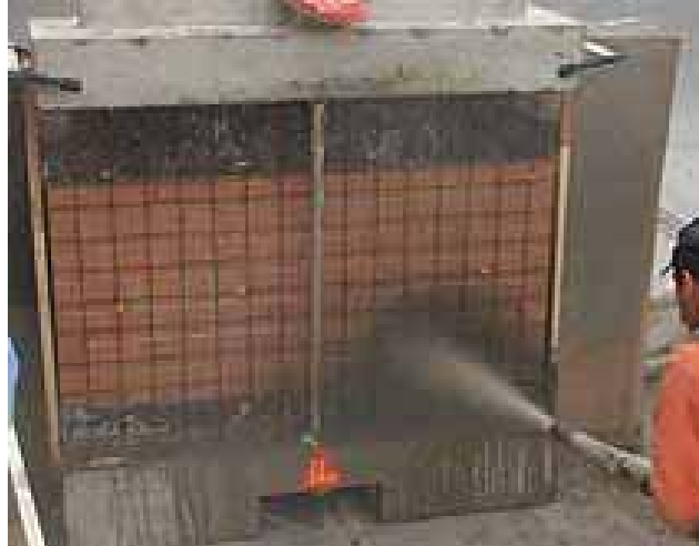
FIGURA 5 - JATEAMENTO DE ARGAMASSA OU DE CONCRETO (ELGAWADY ET AL. 2004)
